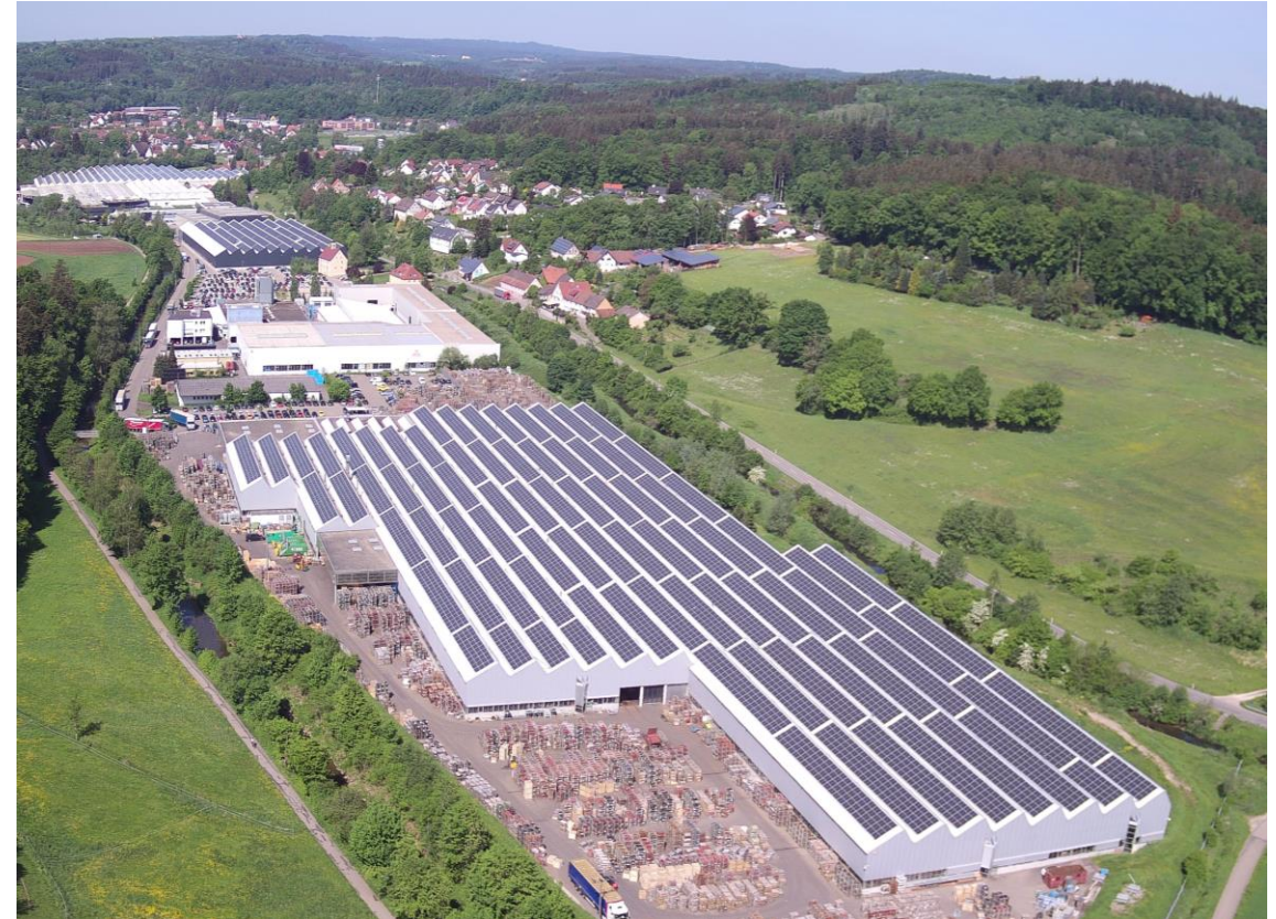
Bild: 10 MWp Dachanlage der Fa. Kessler + Co.GmbH+Co.KG in Abtsgmünd
