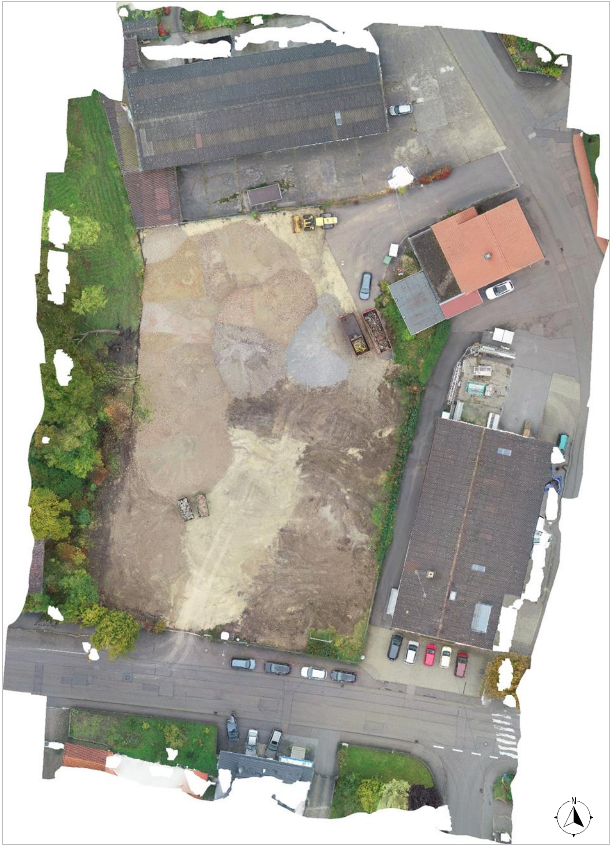
Abbildung 1: Luftaufnahme des Bretzge-Areals nach dem Abbruch des Gebäudes im Juli 2021.
